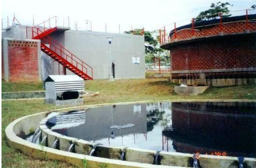
Fotografía 1. Reactor UASB
