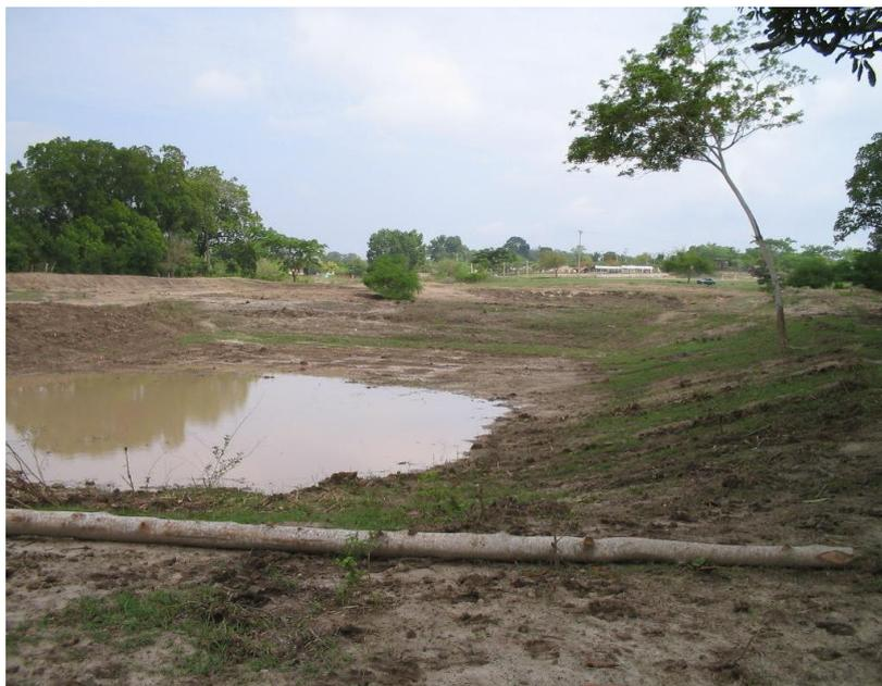
Fotografía 5. Construcción inconclusa de Lagunas de Oxidación en el municipio de Morroa
