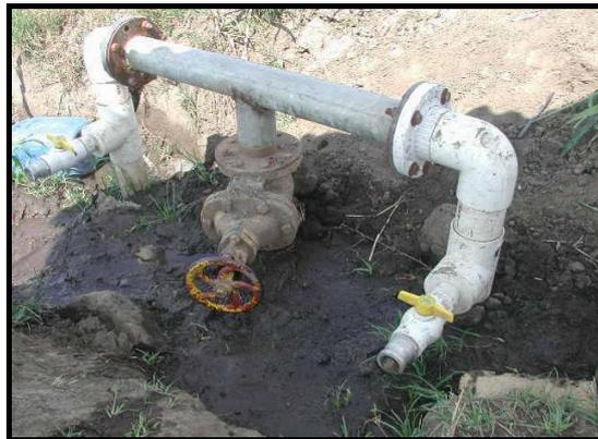
Foto 14: toma tubería principal red de distribución de RLAF La Ondina
