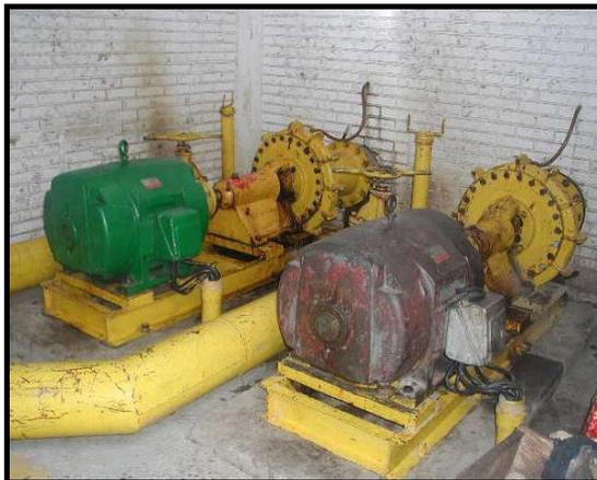
Foto 10: cabezal de riego por aspersión La Ondina
