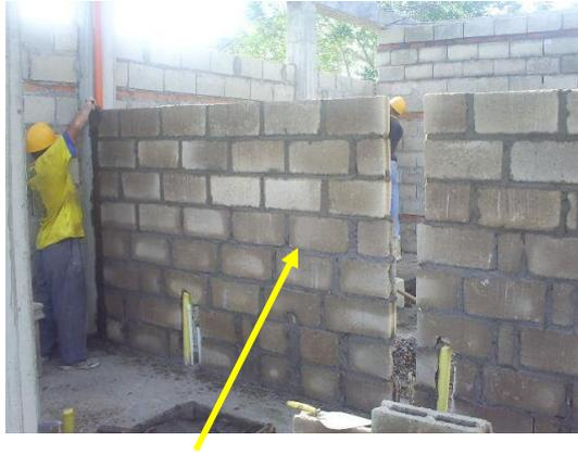
**Figura 14: Detalle de levante en ladrillo tolete hueco**
