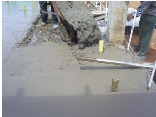
**Figura 10: Fundición en concreto de placa de contrapiso**
