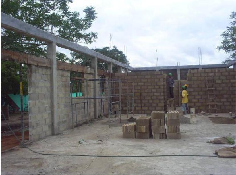
**Figura 3: Detalle levante muro en block abusardado o texturizado**
