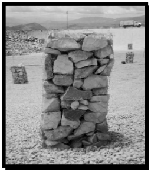
Figura 10. Chimeneas para evacuación de gases.
