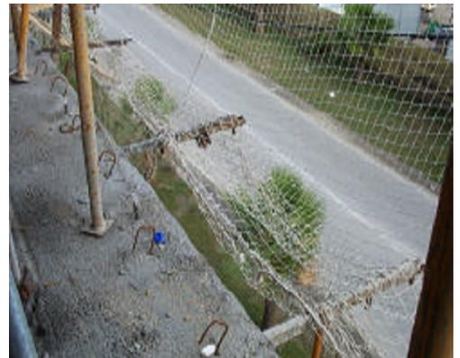
**Figura 33.** Aspecto de una obra en construcción con protección de redes tipo horca.
