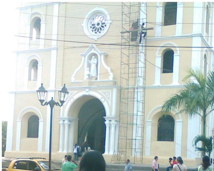
**Figura 69.** Trabajos en altura realizados en la fachada sin ningún tipo de protección. Almacén Beatriz
