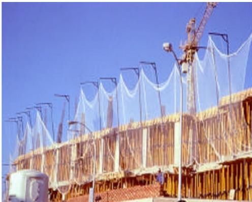
**Figura 32.** Sujeción de la red al forjado.
