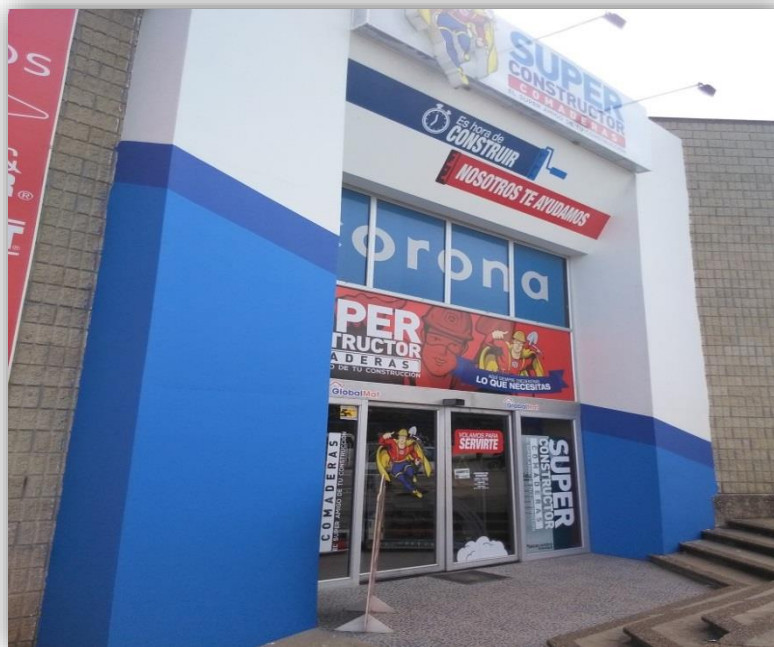
Fachada Súper Constructor Comaderas año 2015. Fuente: Archivo personal del autor.
