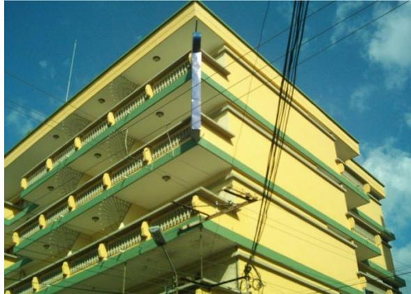
Simetría en elevación. Simetría respecto a dos ejes.
