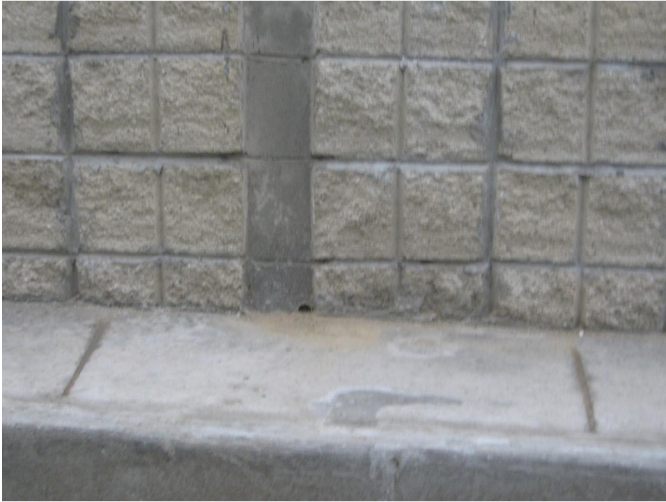
Muro bloque abuzardado
