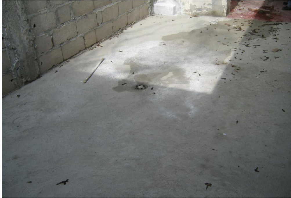
Construcción de plantilla
