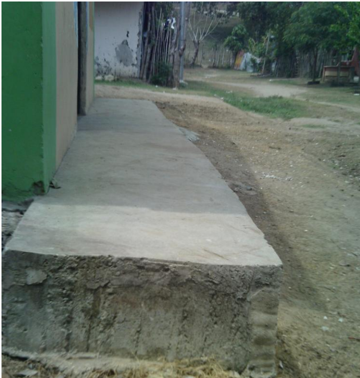
Construcción de andén
