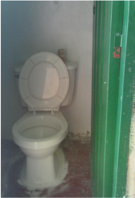
Suministro e instalación de sanitario
