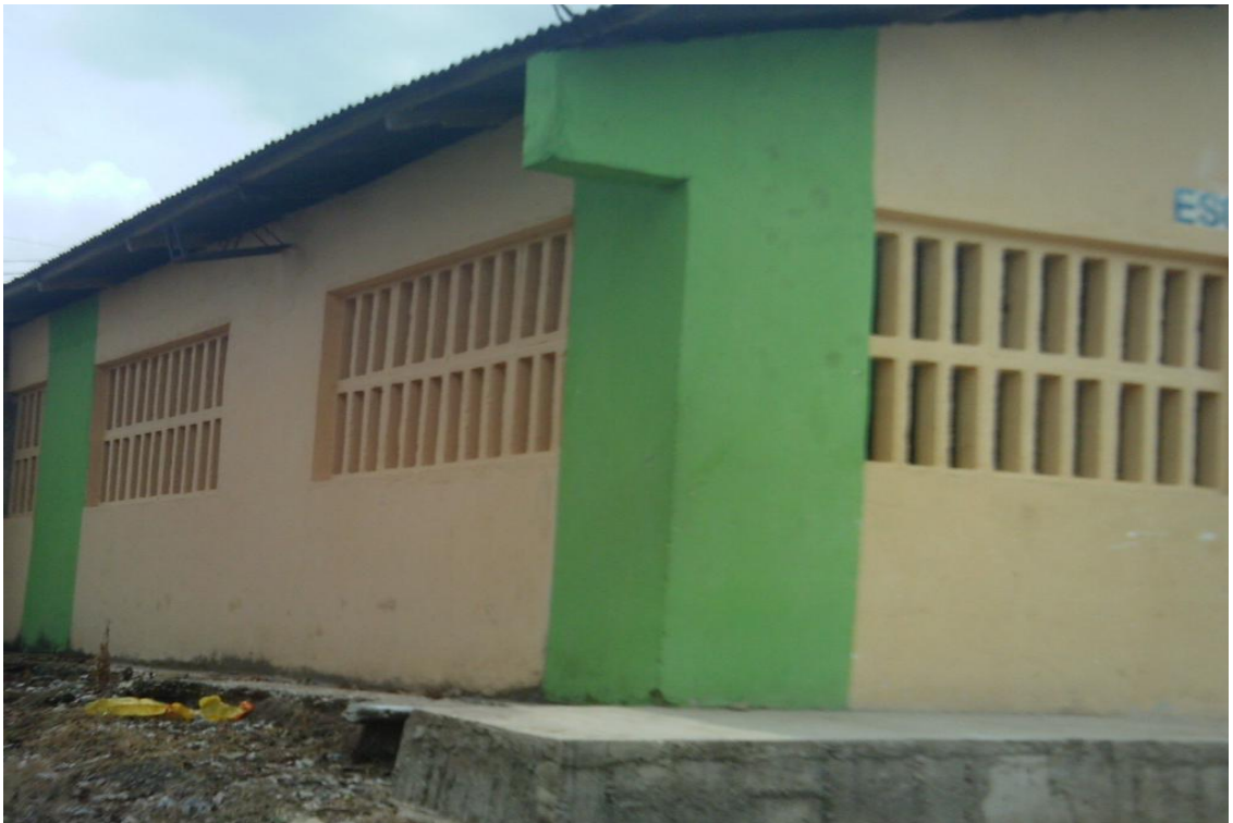
Suministro y aplicación de pintura tipo I
