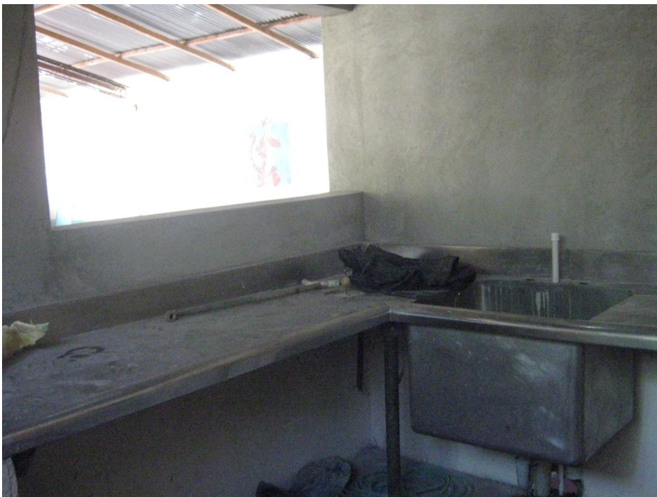
Suministro e instalación de puntos hidráulicos de 1/2"
