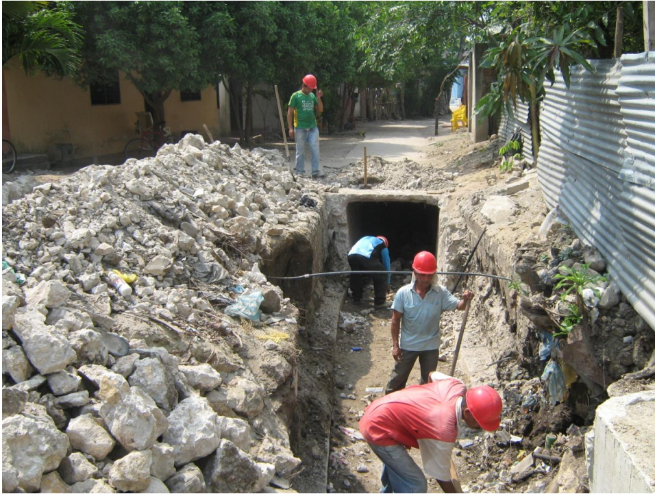
Tubería de agua, y acometida sanitaria
