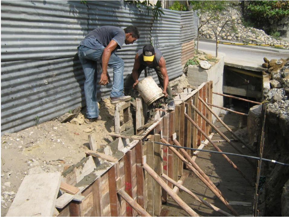
Fundición de muros laterales
