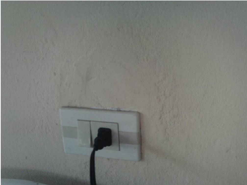
Suministro e instalación de toma corriente
