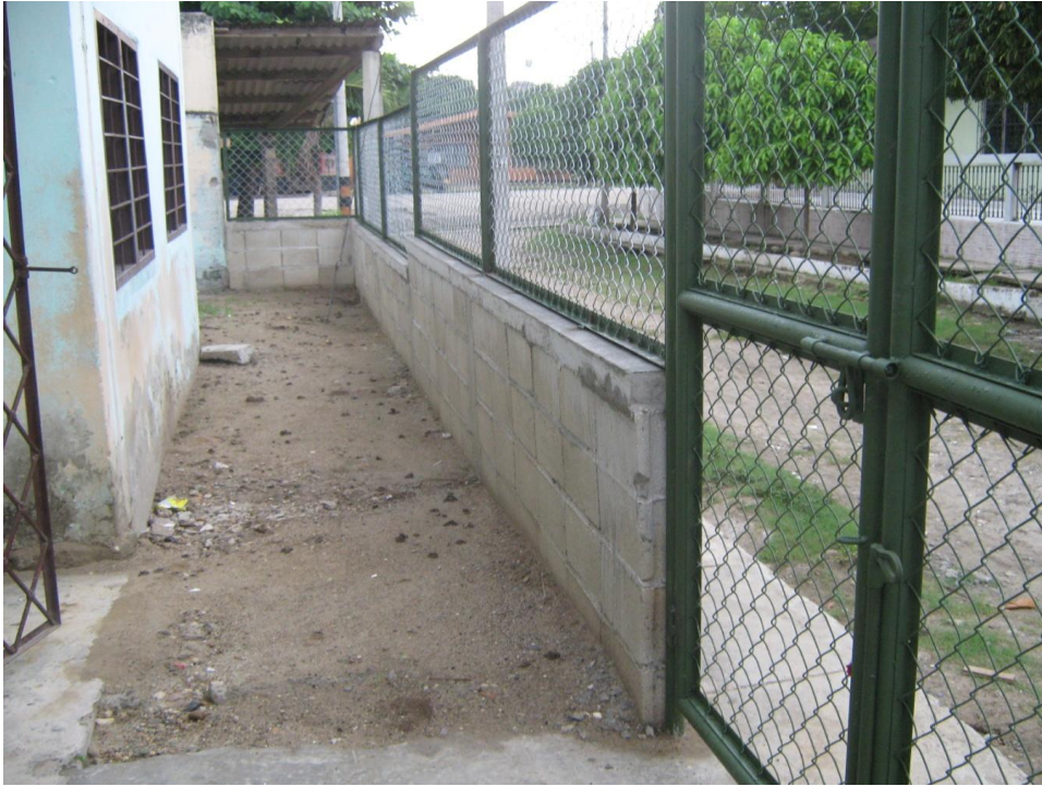
Muro bloque abuzardado
