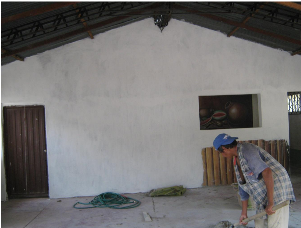
Suministro e instalación de puerta en lámina galvanizada
