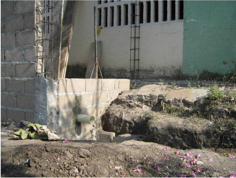
Tubería 4", registro
