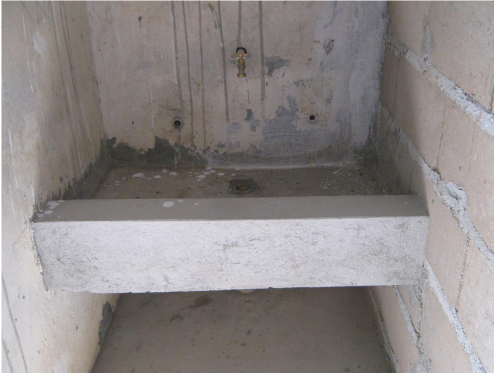
Suministro e instalación de punto sanitario de 2"
