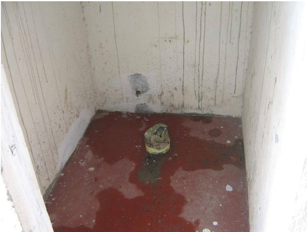
Suministro e instalación de punto sanitario de 4"
