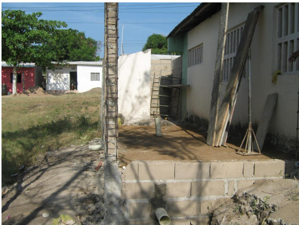
Sobrecimiento, relleno con Material seleccionado
