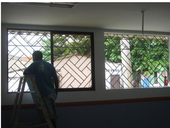
Suministro e instalación de protector y ventana
