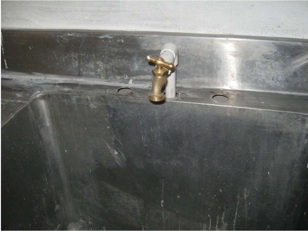
Suministro e instalación de llave de control cobrizada
