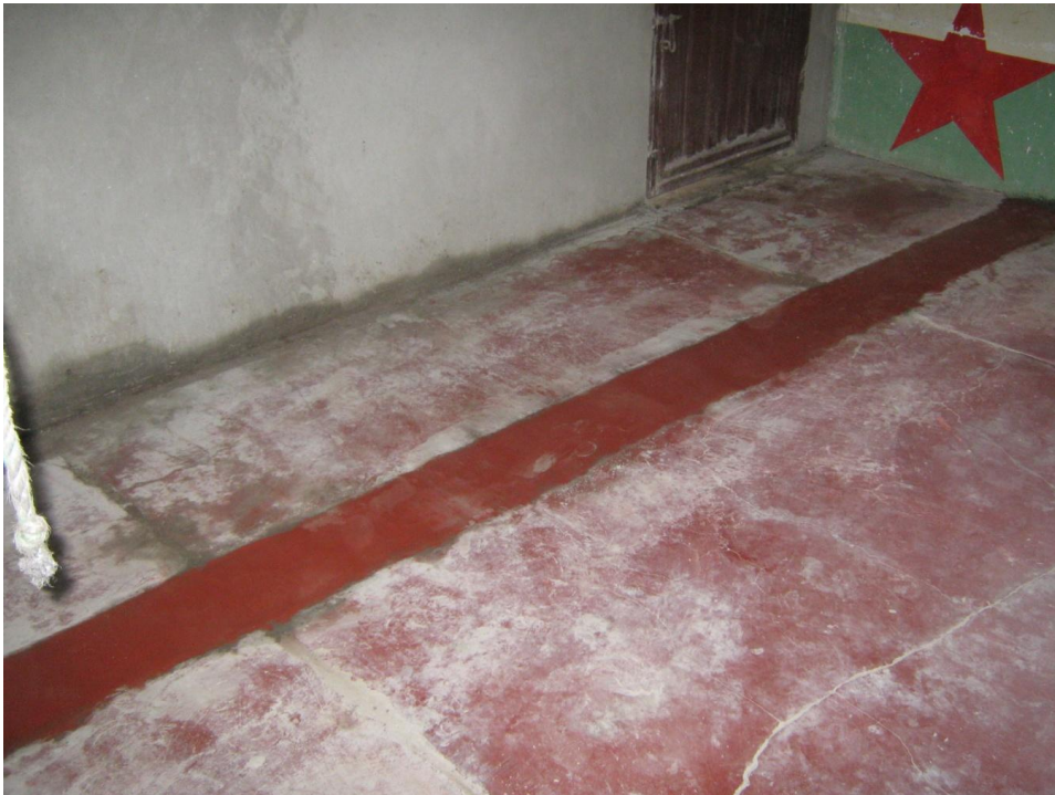
Reparación de plantilla existente
