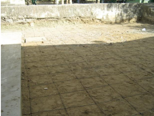
Relleno y acero
