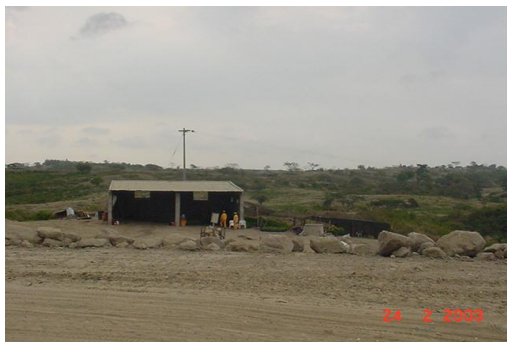
Instalaciones y vías dentro del relleno.
