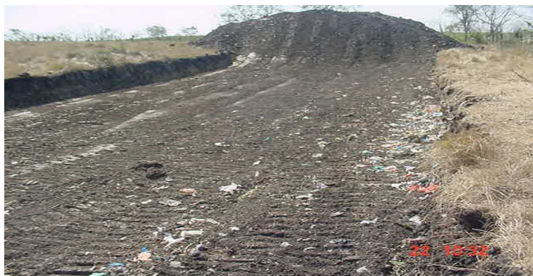
Cubrimiento de celdas para dar fin a la clausura del relleno.
