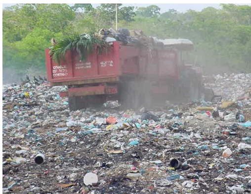
Desorganización en del frente de trabajo.
