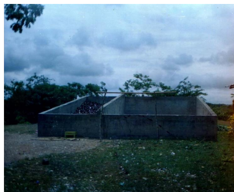
Instalaciones para la clasificación de materiales reciclables (vidrio)
