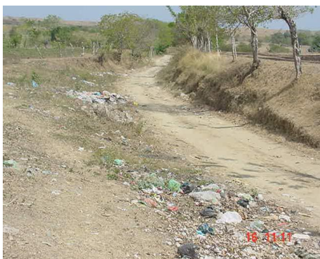
Disposición de basuras al las de las vías.
