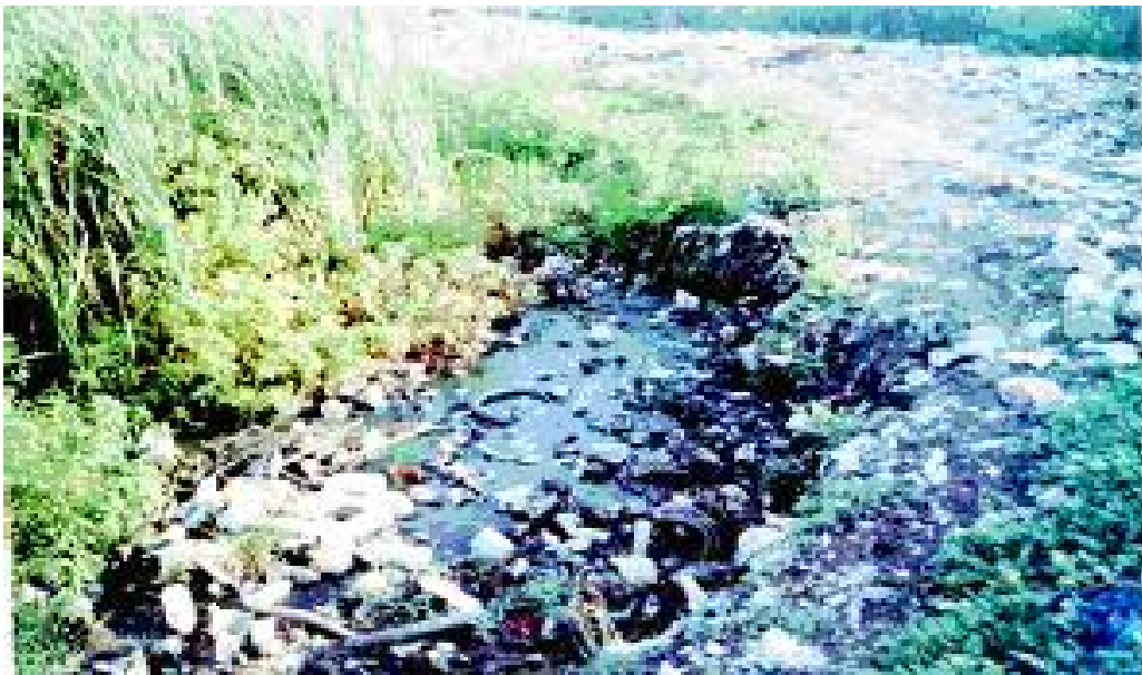
12.5 LAGUNA DE OXIDACIÓN
