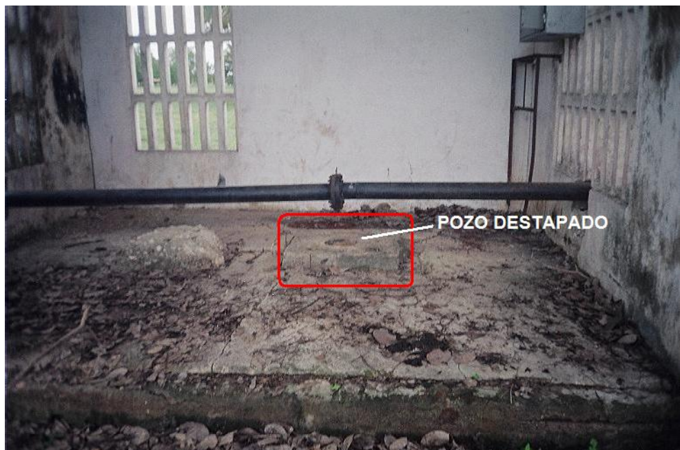
12.2 POZO ABANDONADO DEL SISTEMA DE ACUEDUCTO LOCALIZADO EN LA FINCA TRES PALMA
