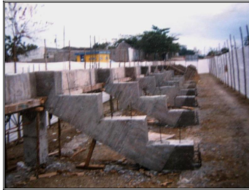
Foto10. Descimbrada de Gradass
