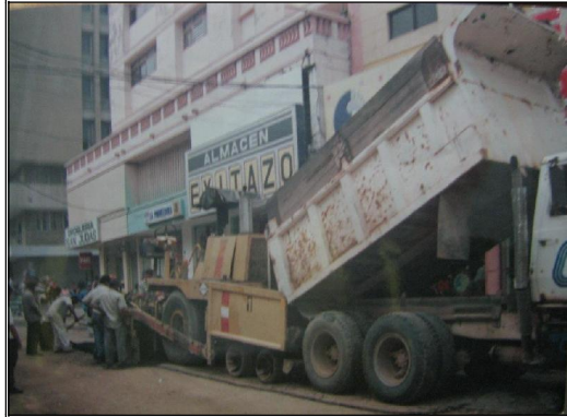
Foto 15. Colocación de material
