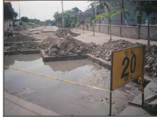
Foto 12. Señalización de trabajos
