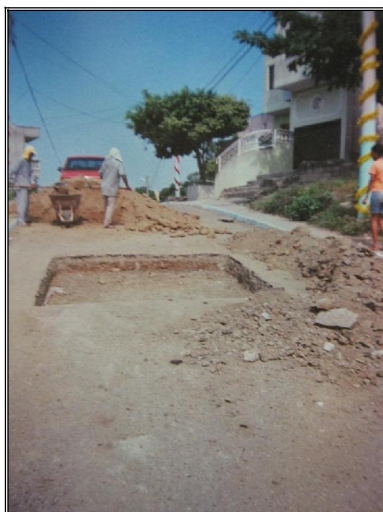
Foto 4. Colocación de material de Base
