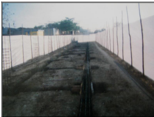
Foto 6. Colocación de acero para vigas
