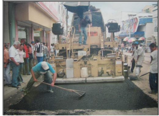
Foto 16. Compactación de material
