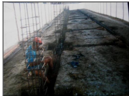
Foto 7. Colocación de acero para columnas
