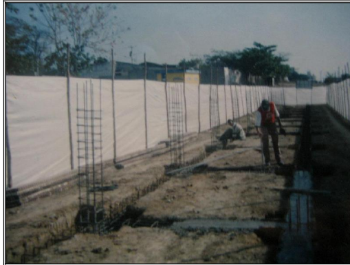
Foto 8. Fundición y vibrado en vigas
