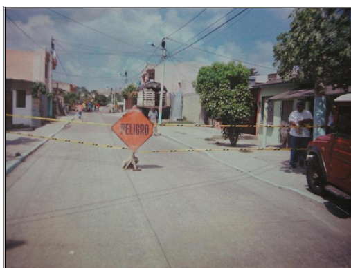
Foto 1. Localización y Señalización de zona de Labores
