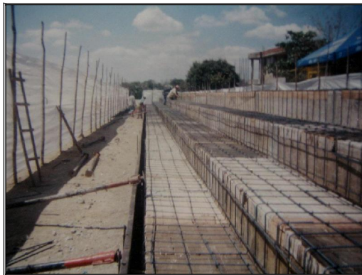
Foto 9. Colocación de acero para Gradas
