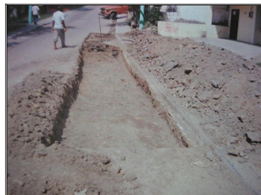
Foto 5. Compactación de Base
