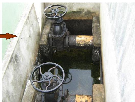
**Fotografía 20. Válvulas que controlan el paso del AR a los sedimentadores primarios.**
