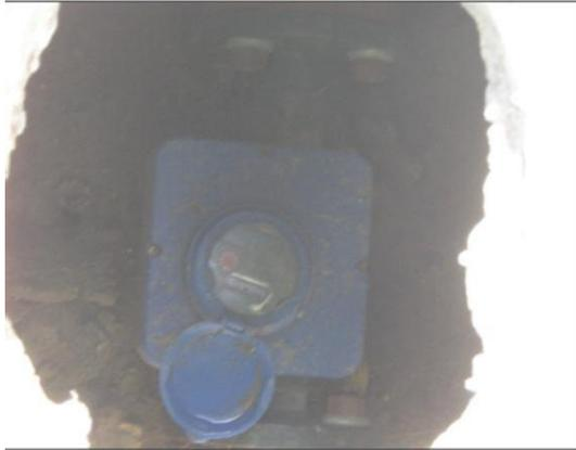
Fotografía 34. Macromedidor de agua potable Sappel.
