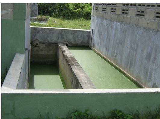
Fotografía 8. Vista externa de los Sedimentadores Secundarios.
