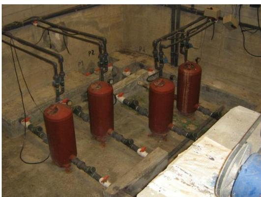
**Fotografía 21. Equipos Hidroneumáticos bombean el AR a los filtros percoladores.**
