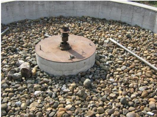
**Fotografía 48. Brazo distribuidor en mal Estado.**
