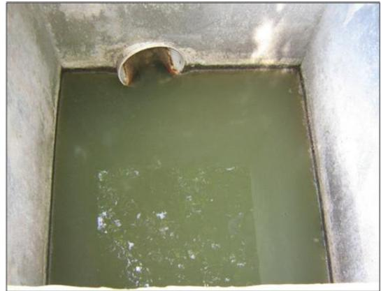
Fotografía 37. Colector Final (punto de muestreo).
