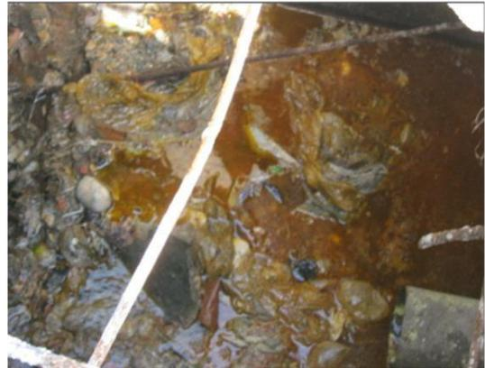
**Fotografía 31. Registro colector 1. Con presencia notable de grasas.**
