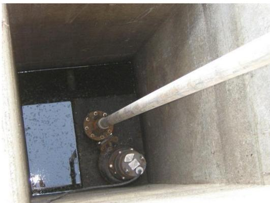
**Fotografía 46. Bomba Sumergible Marca Tsurumi.**
