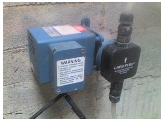
**Fotografía 12. Sistema de dosificación de Cloro.**
