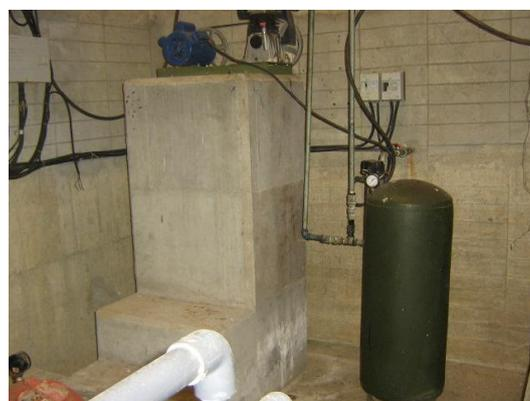
**Fotografía 22. Compresor y tanque dosificador de aire.**
