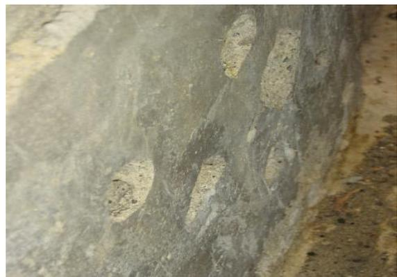
**Fotografía 16. Orificios de drenaje del lecho.**
