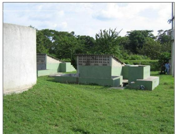
Fotografía 29. Descarga de los Biofiltros a los sedimentadores por acción de la gravedad.
