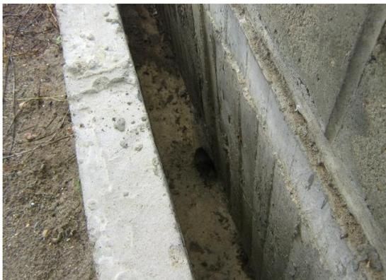
**Fotografía 17. Canal de drenaje del Lecho de secado de lodos.**
