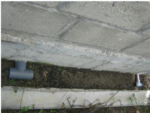
**Fotografía 15. Tees de distribución de lodos al lecho de secado de lodos.**
