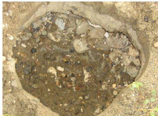
**Fotografía 18. Capas de Arena y Grava Que conforman el lecho de lodos.**
