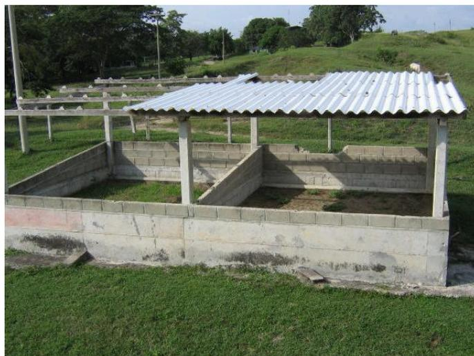
**Fotografía 14. Eras de Secado de Lodos.**
