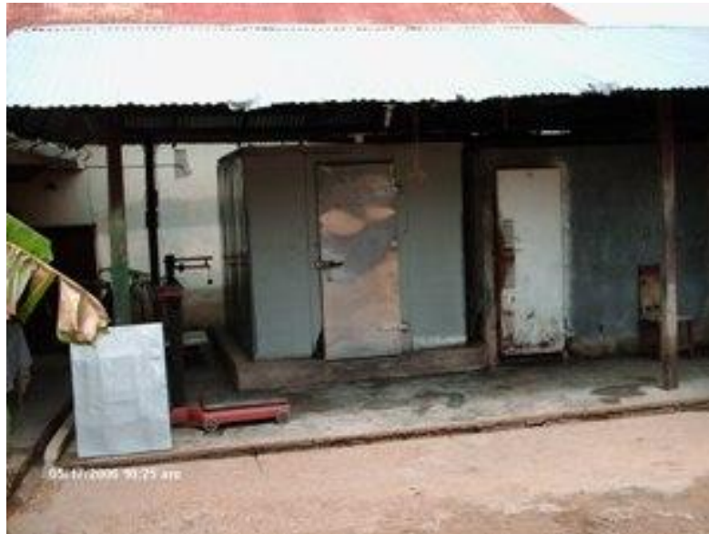
Cava de Refrigeración
