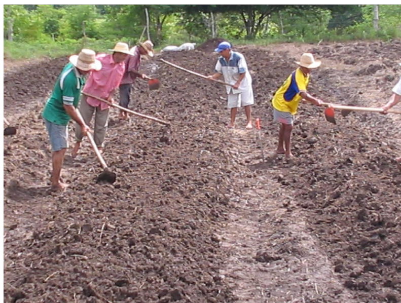
Foto N° 28. Construcción de eras por parte de los miembros de la comunidad de Betulia
