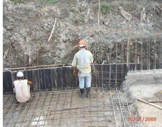
Armado y colocación del acero de refuerzo para placa de fondo y paredes del canal
