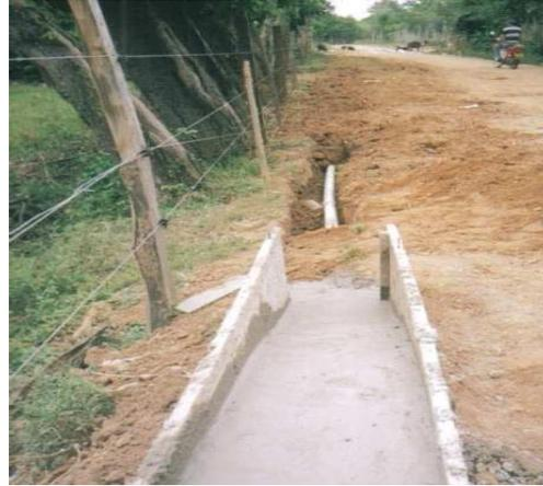
Estructura en concreto para protección de la tubería instalada
