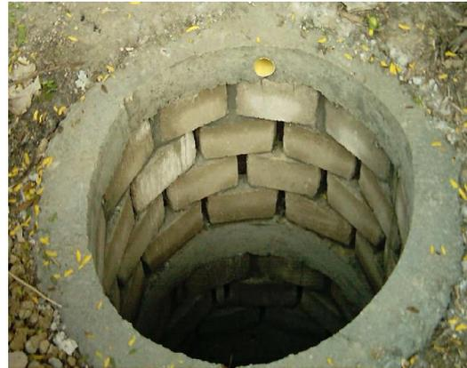
Construcción de Viga cemento, levante de bloques, viga intermedia y superior del pozo séptico
