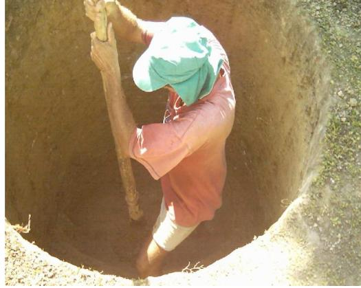
Excavación del pozo séptico 2m \* 1m
