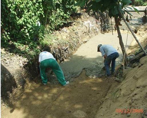
Colocación del solado sobre material compactado.
