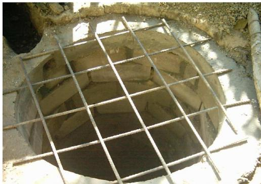
Armado del hierro para tapa de pozo séptico
