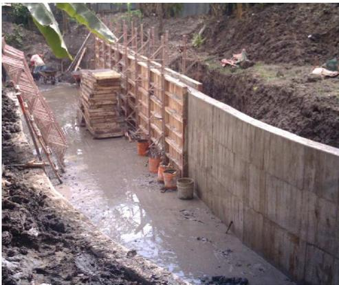
Desencofrado de los muros del canal
