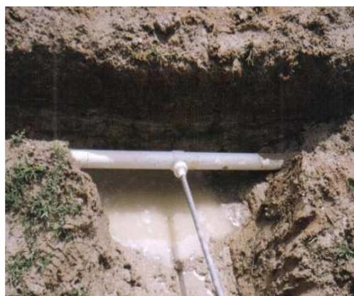
Relleno de zanjas con material del sitio e Instalación de Acometidas Domiciliarias
