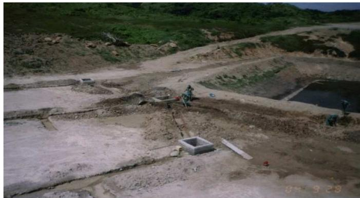
Figura N° 19. Empalme de los filtros con los colectores
