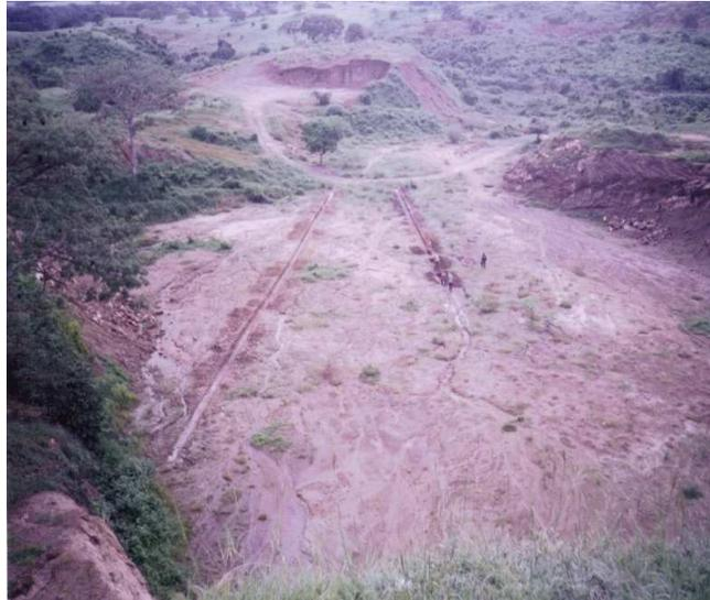
Figura N° 16. Vista de las zanjas para los filtros encargados de recolección y transporte de lixiviados
