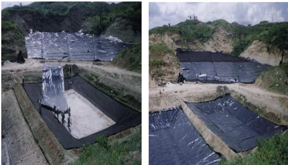
Figuras N° 20 y 21. Colocación de la geomembrana y geotextil para la impermeabilización de las piscinas de lixiviado.
