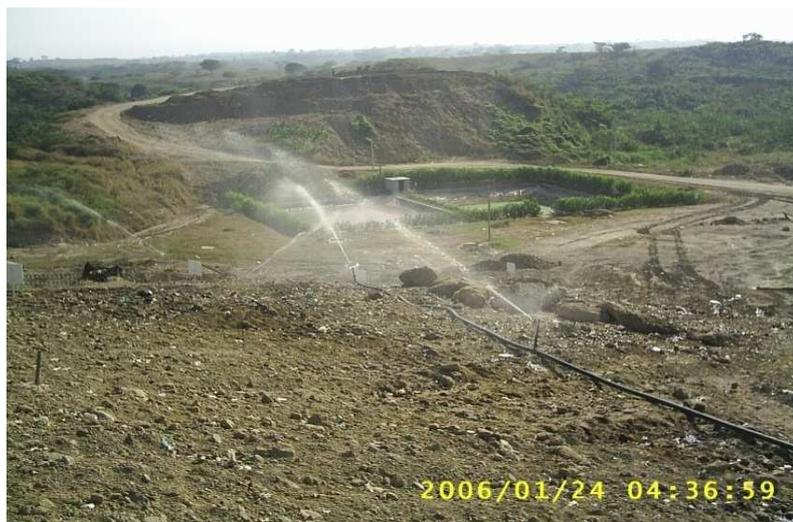
Figura N° 22. Proceso de recirculación de lixiviados.
