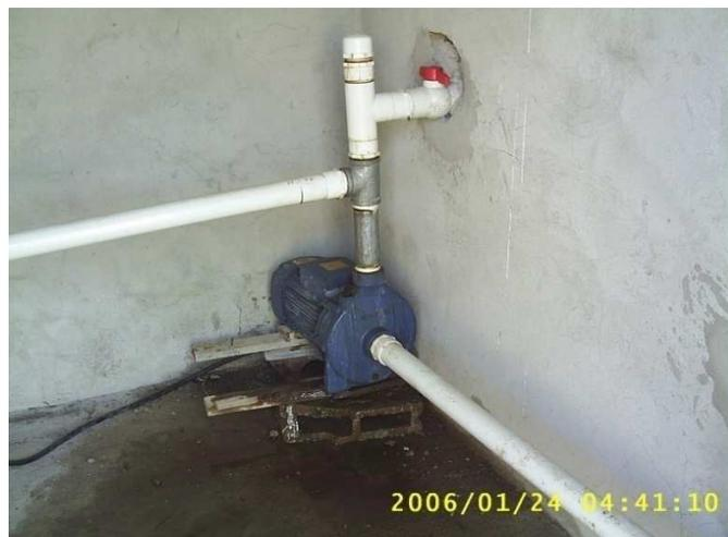
Figura Nº 23. Estación de bombeo, para la recirculación de lixiviados
