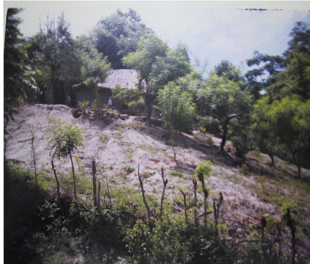
Fotografía N° 11. Vivienda del Barrio El Oasis
