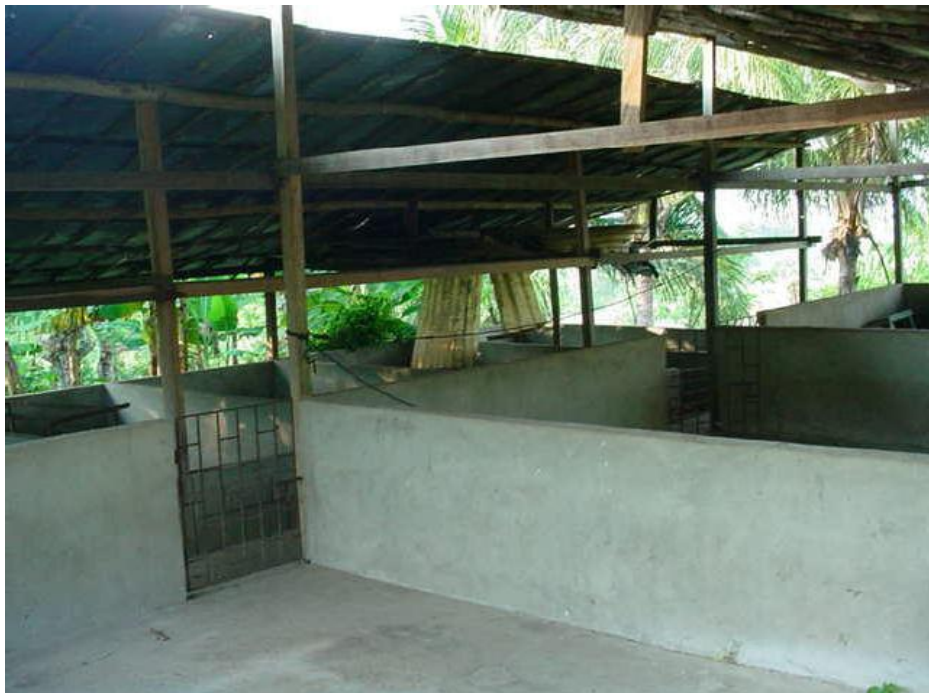
INFRAESTRUCTURA PARA ARMADILLO
